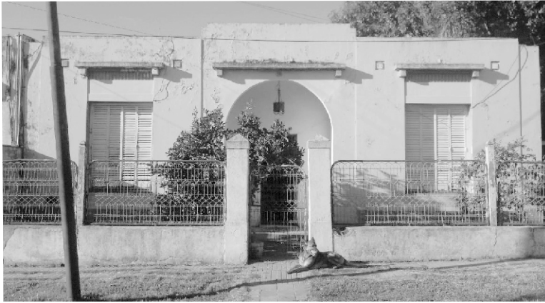
Única casa del barrio que se mantiene con su frente original
